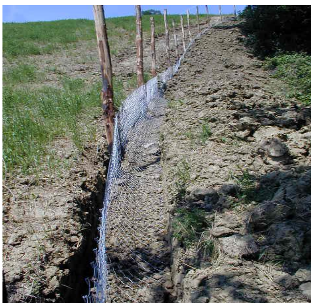
Interramento della rete (in funzione anti-volpe)
