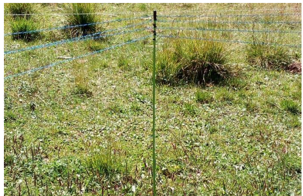
c) Necessità di manutenzione in più punti per evento notturno, con danneggiamento di uno dei tre fili conduttori (25.07.2017)
